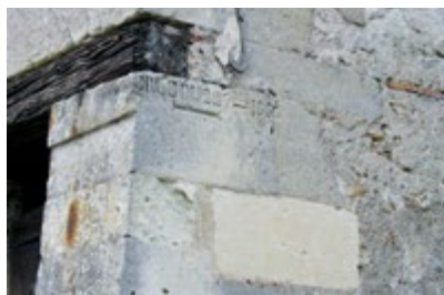
Crue de la Loire 1856 - Station de pompage d'eau potable du Val Fleuri
