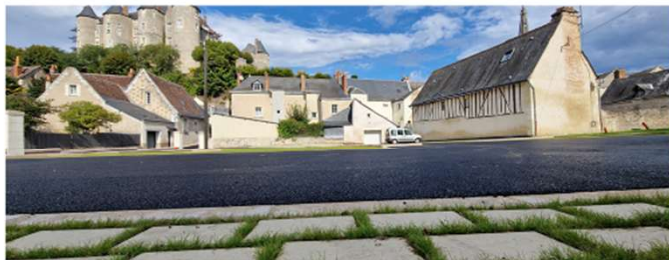
Structure stationnement béton balayé drainant
