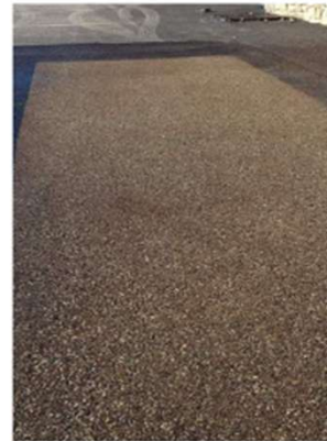
Voirie légère / Plateau surrélevé enrobés clairs hydrodécapés
