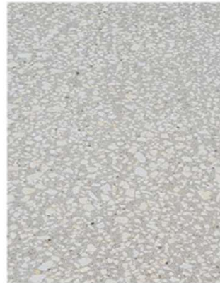
Zone de trottoirs et cheminements piétons ponctuellement circulables béton bouchardé
