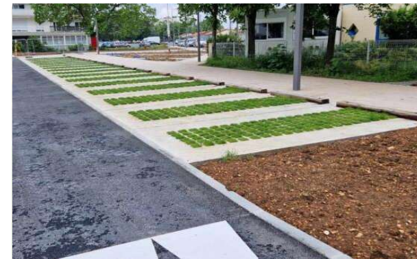
Stationnement dalle alvéolaire type «nidagravel» ou similaire sur structure drainante
