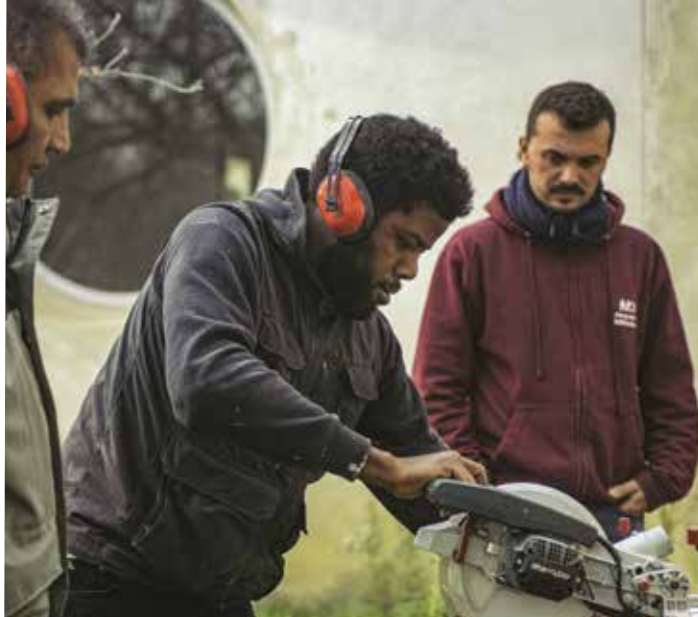
Les Compagnons bâtisseurs en action sur un chantier solidaire © Compagnons bâtisseurs
