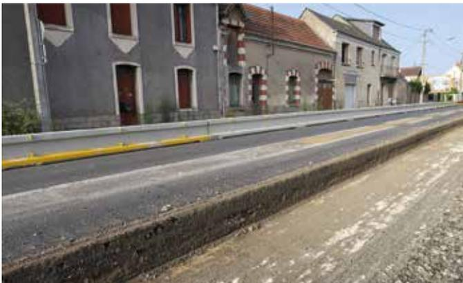
L'État a repris début août des travaux de renforcement de la digue de la Loire entamés en 2011. Il s'agit de réaliser une paroi étanche qui va venir consolider la digue, comme du côté de Primagaz.
