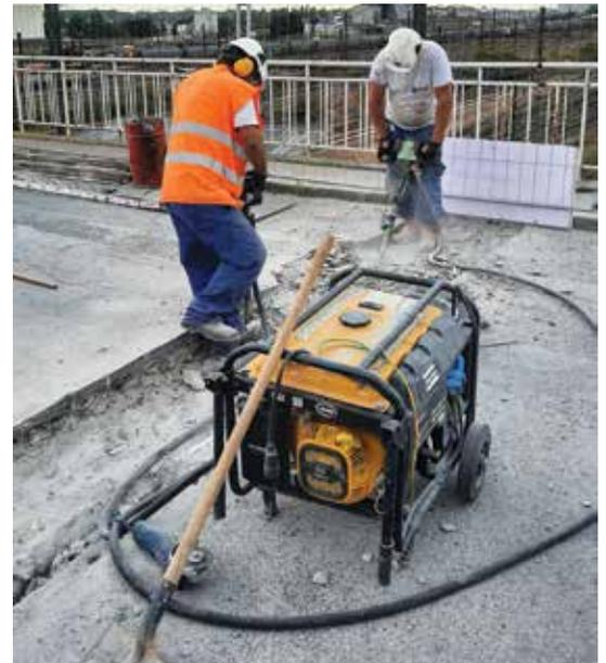
Du 24 au 28 août, des travaux ont été menés par Tours Métropole Val-de-Loire concernant le pont des Épines-Fortes. Le pont, qui est fortement emprunté, était dégradé et rendait la circulation des véhicules dangereuse. Le chantier a permis de réparer le joint du milieu, qui sert à la dilatation du béton pendant les fortes températures.
