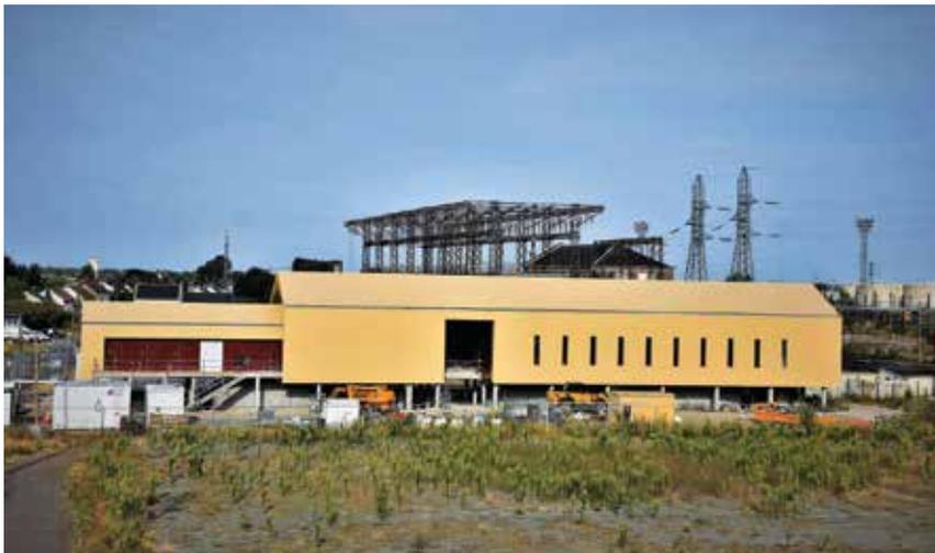
Depuis mars 2019, des travaux sont réalisés au poste de transport électrique RTE (Réseau de transport d'électricité), rue des Épines Fortes. Le poste en structure métallique, mis en service dans les années trente, a été démonté car il n'était plus possible de l'entretenir. Un nouveau poste de 600 m<sup>2</sup> a été reconstruit juste à côté. La nouvelle construction, sur pilotis, répond aux normes inondations de la commune.
