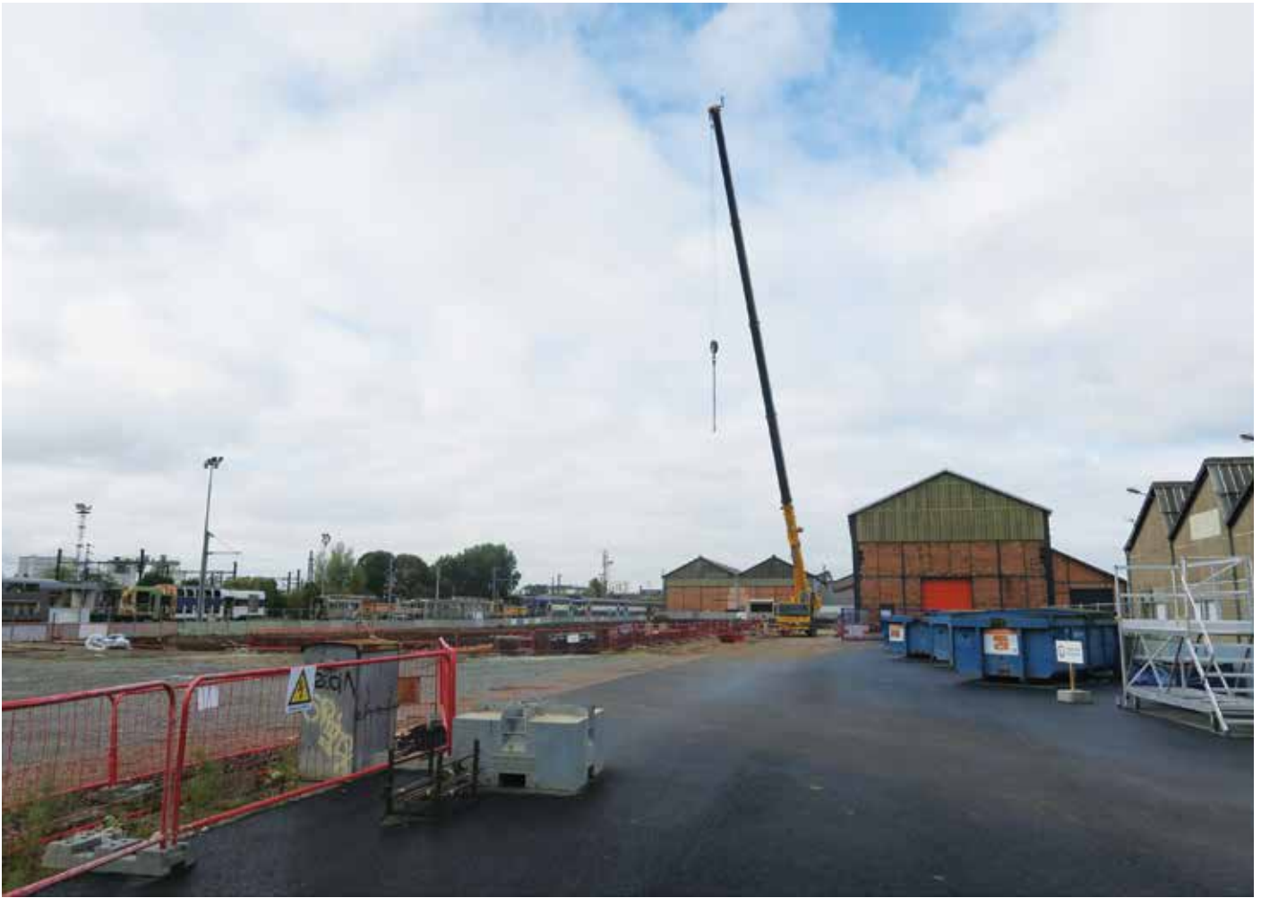
Le chantier est situé dans la partie sud-ouest du site. On creuse une fosse pour travailler sous les trains.
