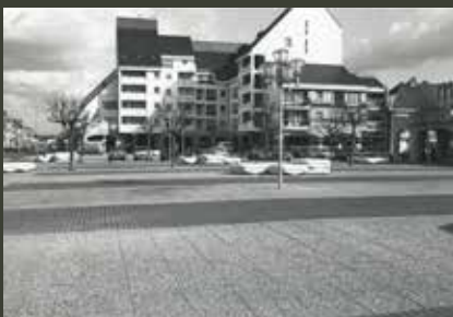
Les travaux de réaménagement sont terminés, 1981
