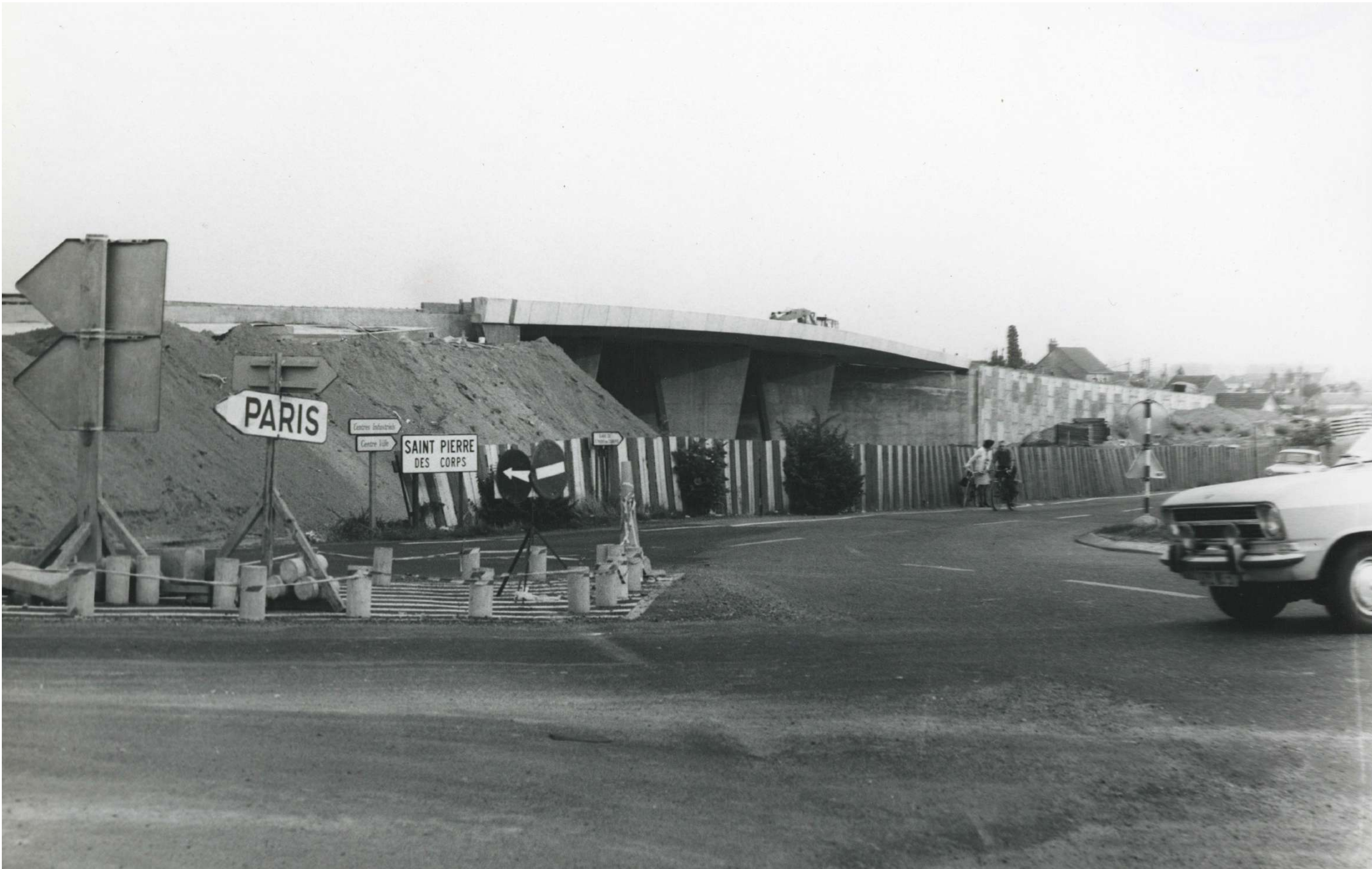
Construction du pont de l'autoroute A10 en 1971 AMSPDC - 2Fi2319
