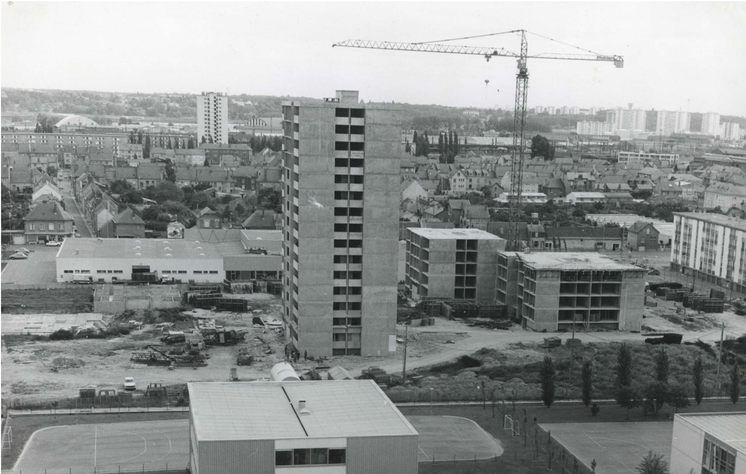
Construction des tours derrière le centre commercial de la Rabaterie en 1970 AMSPDC - 5Fi151
