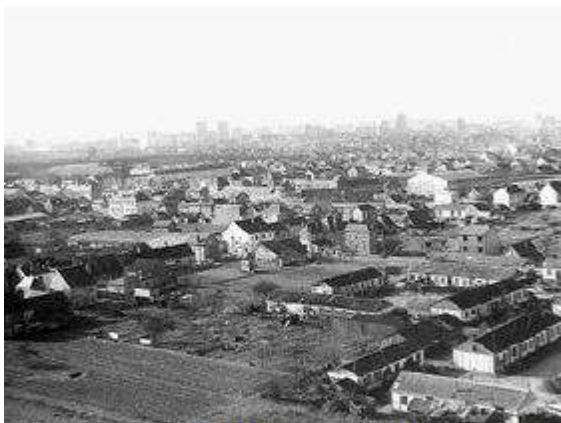
Le site de la Rabâterie avant la reconstruction Source : Archives municipales de Saint-Pierre-des-Corps
