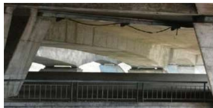
Le pont de l'autoroute : la découverte d'une architecture monumentale
