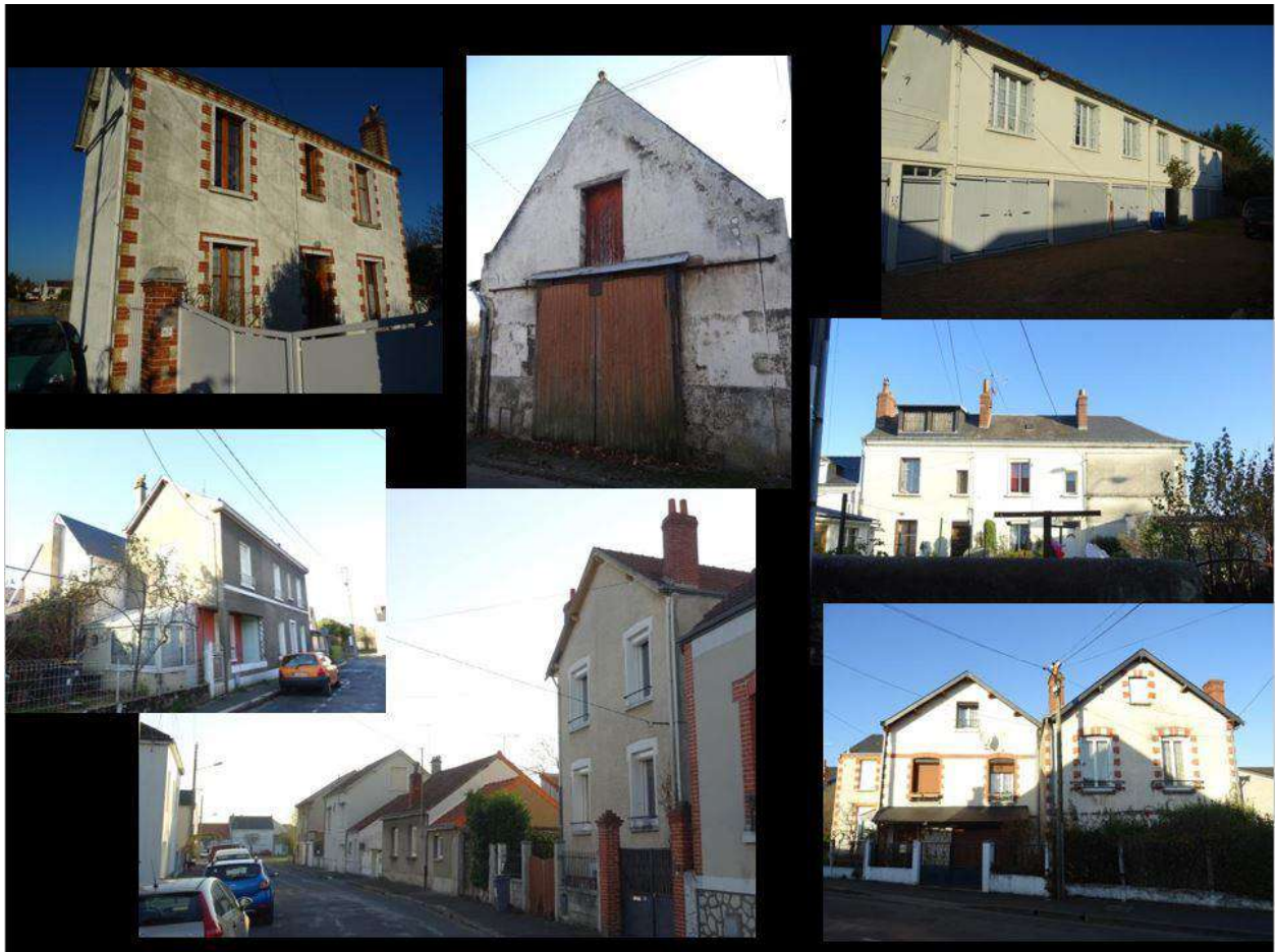
Un bâti diversifié dans son implantation sur la parcelle et par rapport à la rue, des volumes dépassant rarement R+1+C.
