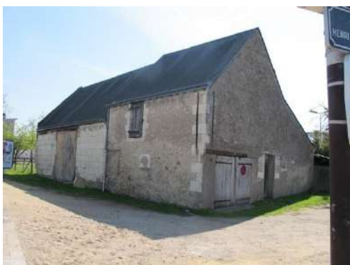
Ferme du Carroi Vognet angle rues Rabâterie/L. Porcher. Grange ancienne et petite longère accolée R+C surélevée.
