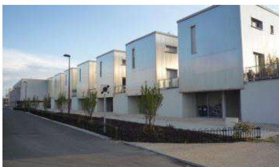
Villa Curie : des maisons de ville de centre urbain intégrant le risque d'inondation
