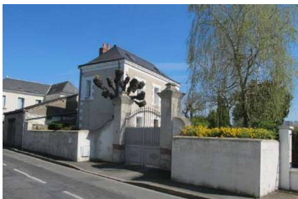
Rue Marceau, maison de maître avec pignon étroit et toiture à quatre pans, trois travées.
