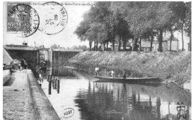
Canal de jonction, aussi appelé "canal de Berry" entre Loire et Cher
