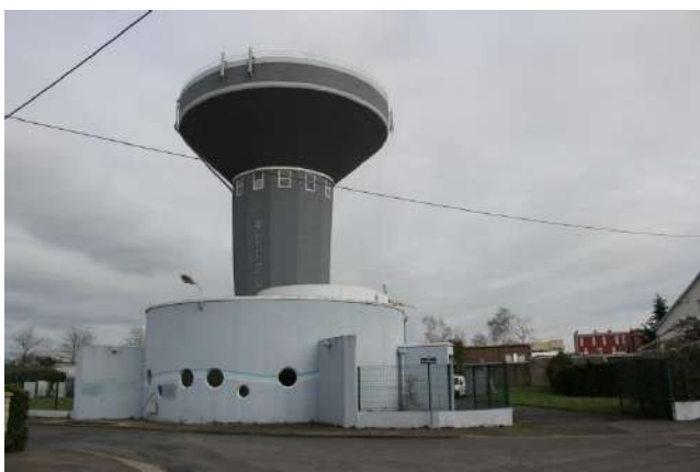
Captage des Sablons
