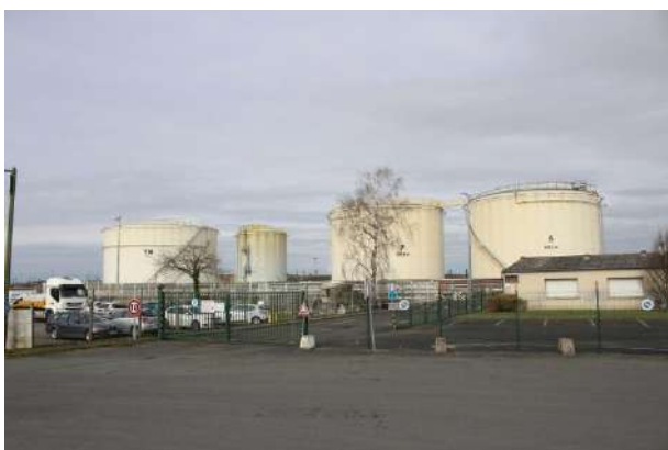
Zone industrielle des Yvaudières
