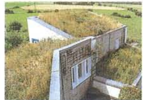
En veillant à ce que l'eau de pluie s'infilte progressivement dans le terrain, et non dans les égouts, on compense en partie les effets néfastes de la construction sur l'environnement.
