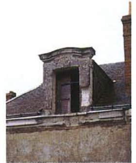
Cette lucarne ancienne de pierre repose sur le mur de façade.
