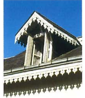
Lucarne ouvragée dont le feston est découpé dans des planches de bois.
